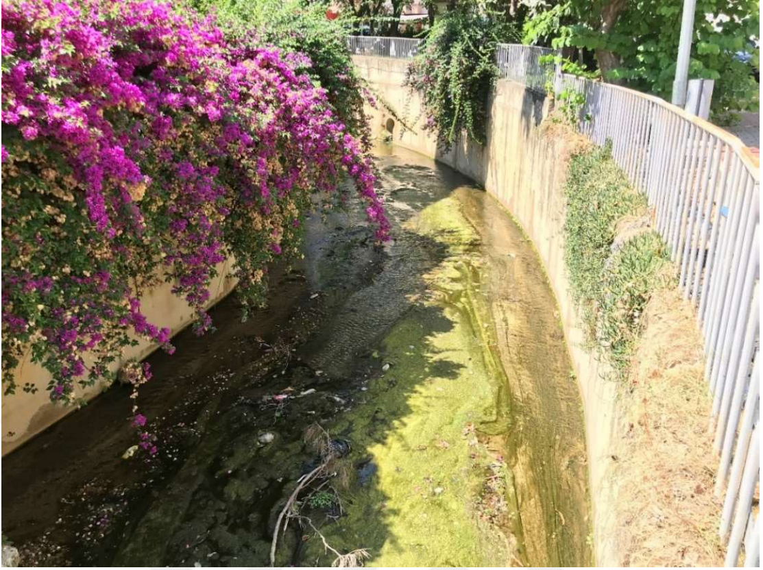
Şekil 4.10 Hacet Deresi Açık Kanal (1+230)
