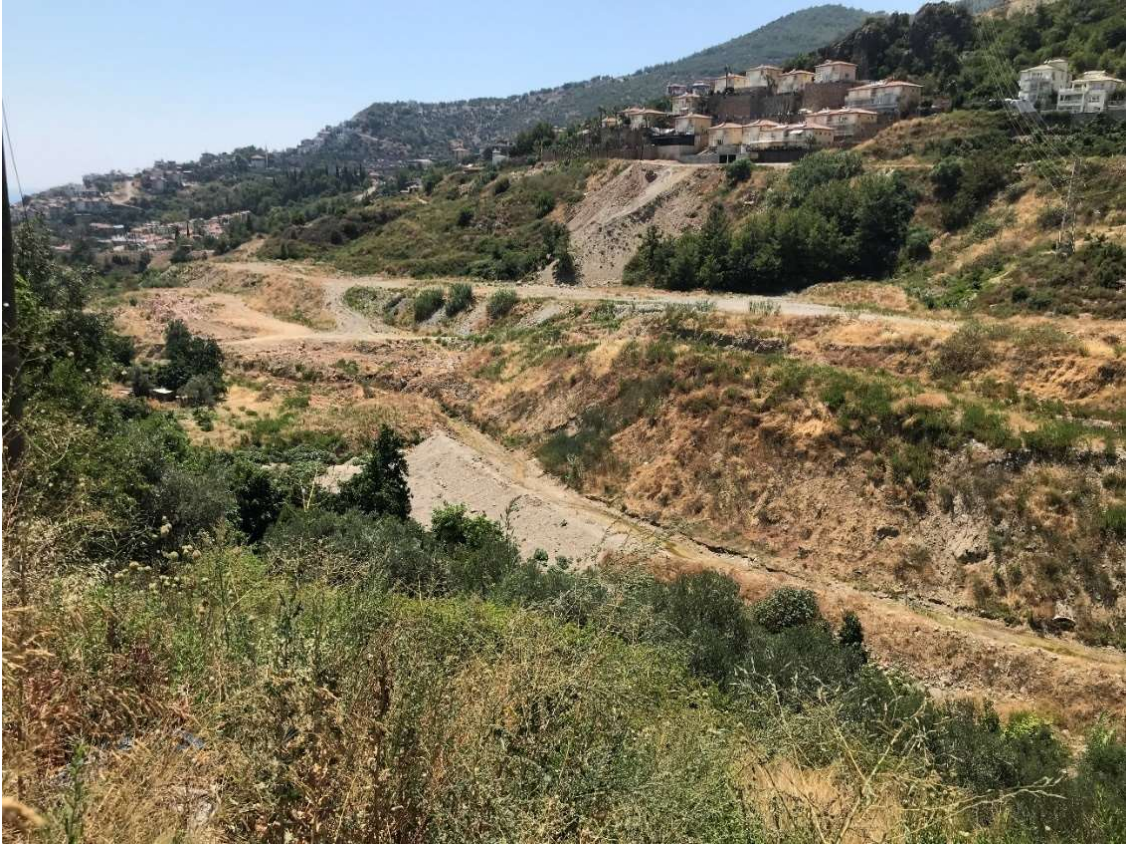
Şekil 5.10 Hacet Deresi Güzergahında Heyelan Potansiyeli Olan Açık Kesim
