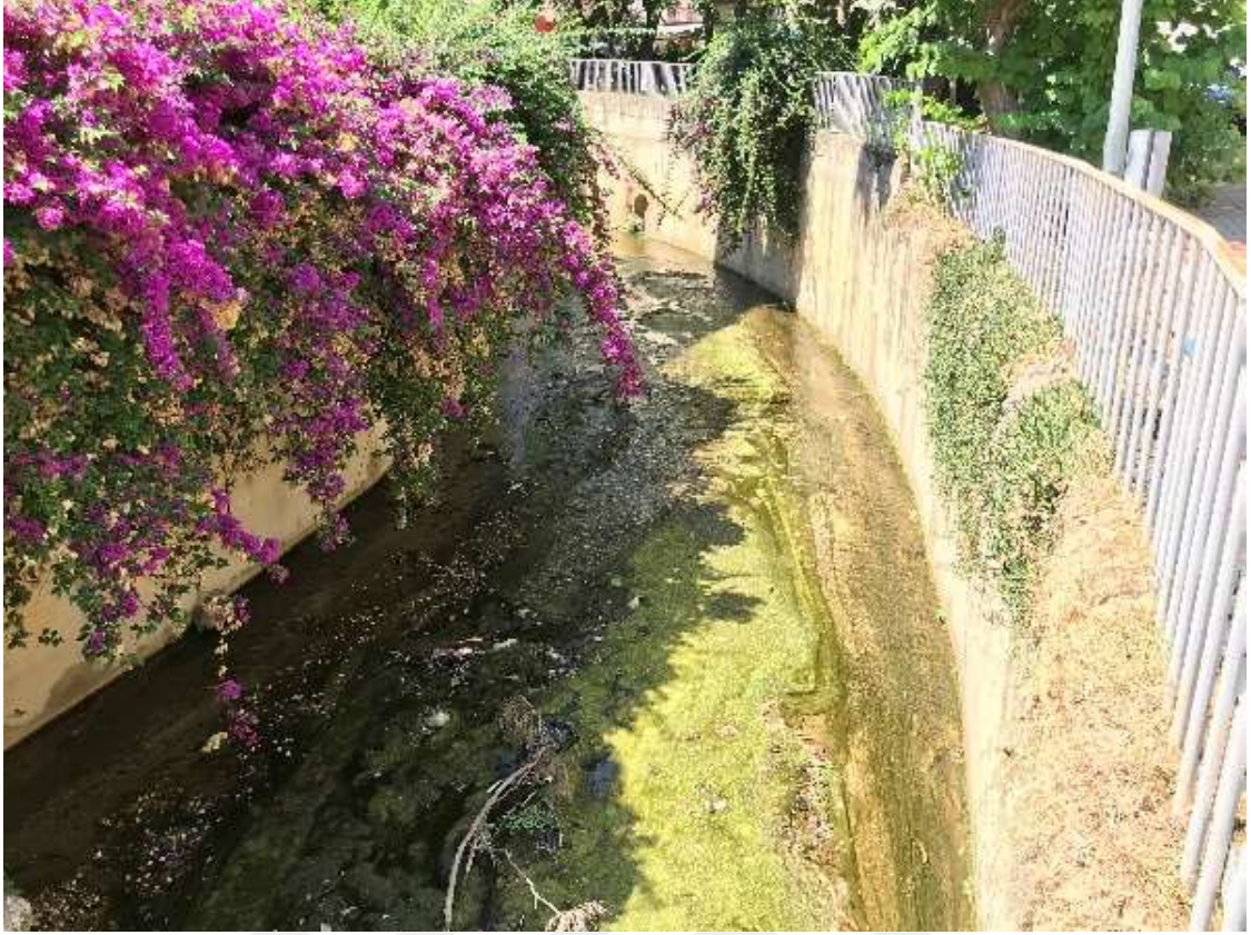
Şekil 5.8 Hacet Deresi'nde Oluşan Yosunlaşma ve Kirlilik
