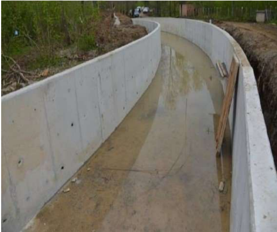
Şekil 2.1 Taşkın Koruma Yapıları (Türk Hidrolik Dergisi, 2019)
