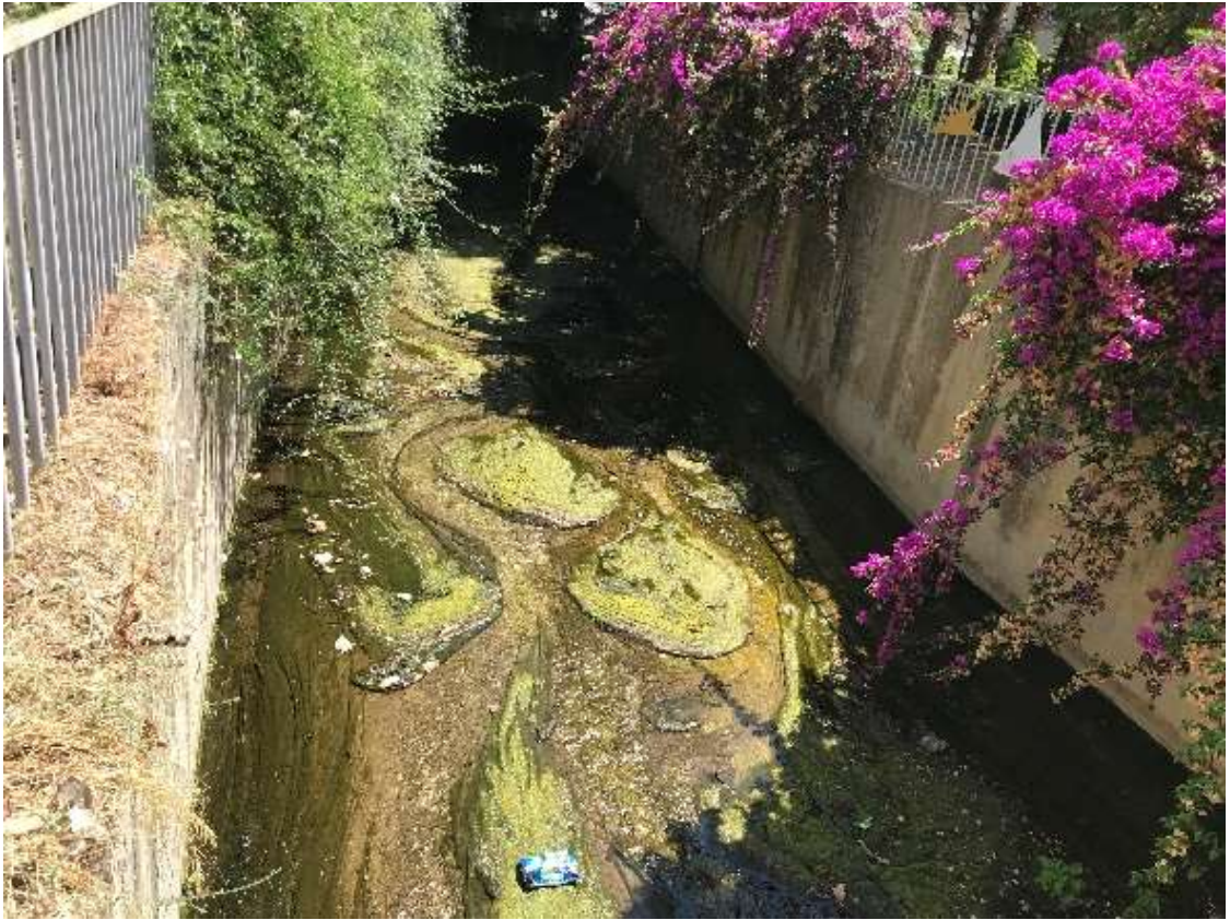
Şekil 5.9 Hacet Deresi'nde Oluşan Yosunlaşma ve Kirlilik
