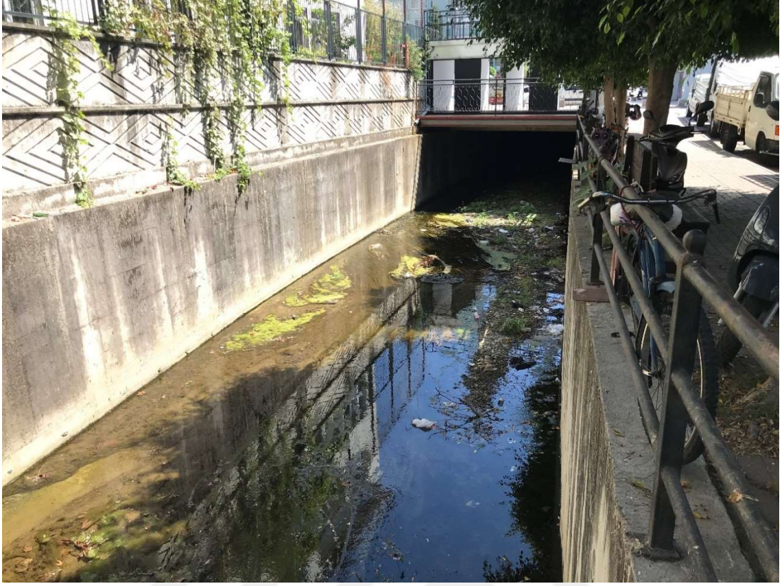
Şekil 4.50 Hacet Deresi'nin Kapalı Kesite Geçtiği Yer (2+945)
