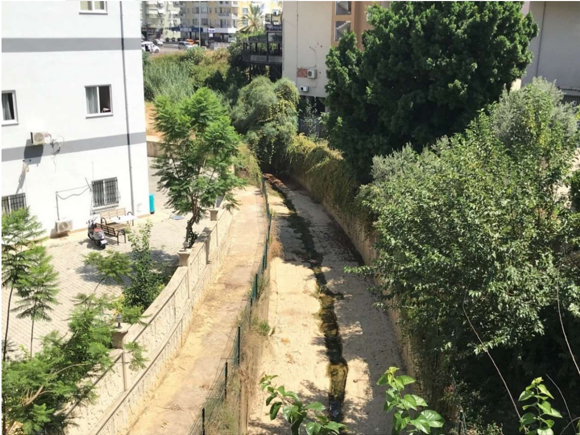
Şekil 4.17 Hacet Deresi Açık Kanal (1+460)
