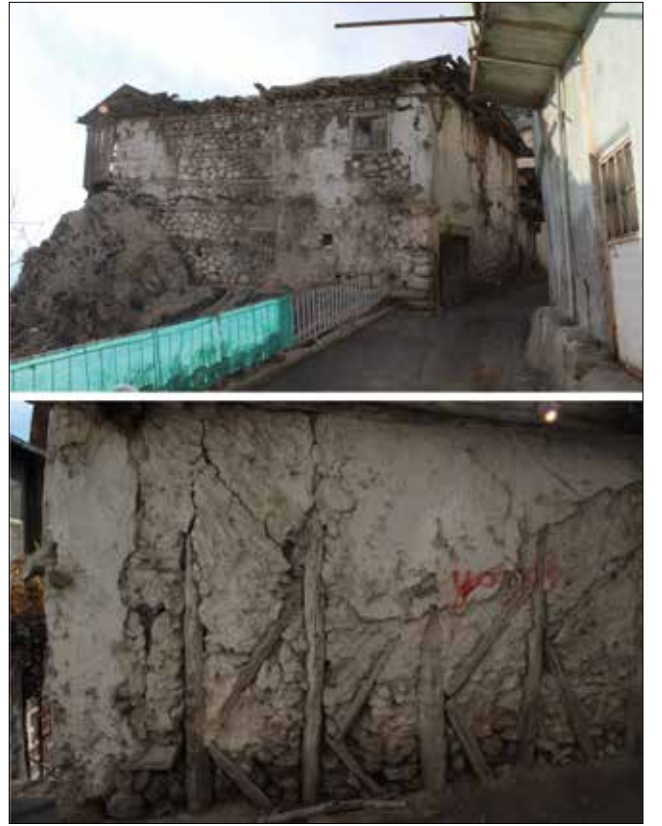
Levha 9. Ermenek kış yerleşimi, duvar yapım teknikleri / Ermenek winter settlement, wall construction techniques (Fotoğraflar, Erkovan)
